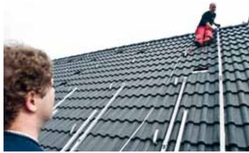
Montaggio su tetto inclinato
