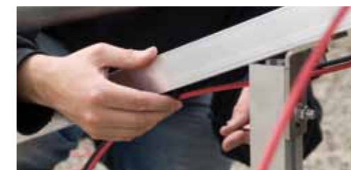
Posa dei cavi
