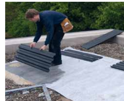
Posa delle piastre trapezoidali Renosol
