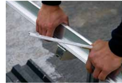
Fissaggio del profilo TS
