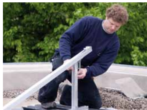
Montaggio degli angolari
