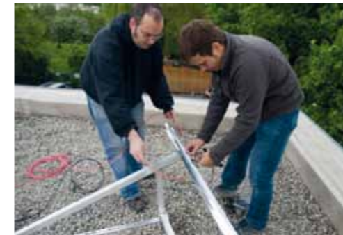
Montaggio su tetto piano
