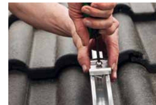
Fissaggio del SafeClick SC
