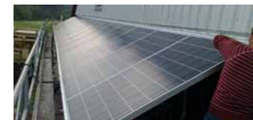
Montaggio su facciata
