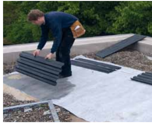
Posa delle piastre trapezoidali Renosol
