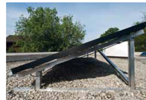
Sistema a montanti verticali
