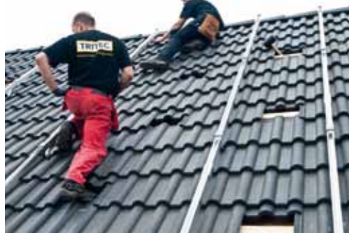
Montaggio dei profili universali
