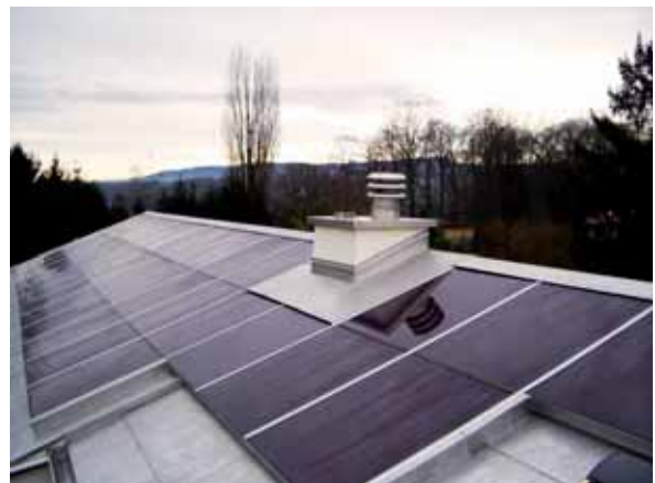
Les panneaux à couche mince Schott ASI sont particulièrement adaptés pour les façades et les toits dont l'orientation n'est pas optimale.
