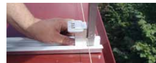
Asegurar el panel del borde con la herramienta de curvar TRI-VENT
