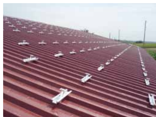
Tejado equipado con perfiles portadores y anclajes de paneles
