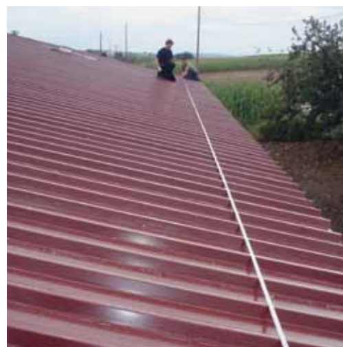
Medición y marcación de la línea inferior.
