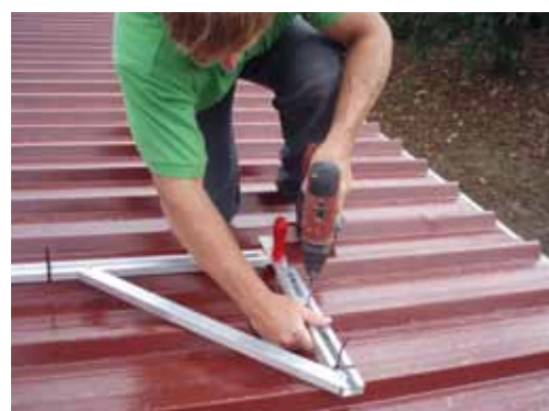
Perforación de la línea inferior con el patrón de perforación
