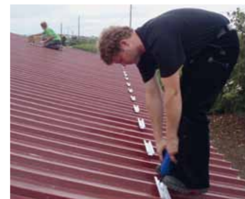
Remachar los perfiles portadores.
