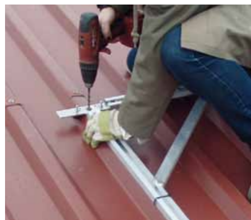
Taladrar en la guía de perforación fija
