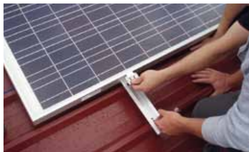
Fijación del panel con el anclaje de paneles TRI-VENT
