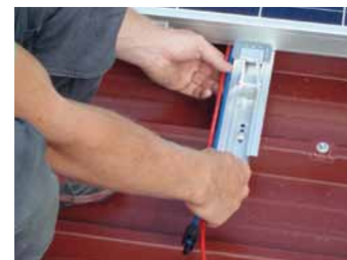
Colocación y fijación de los cables
