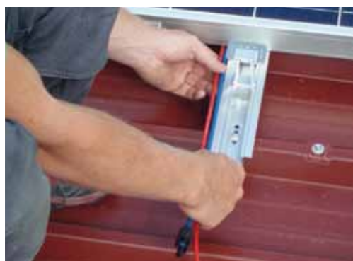
Colocación y fijación de los cables
