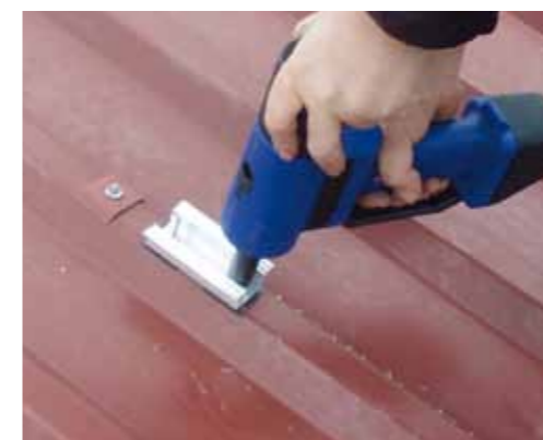
Remachar los perfiles portadores.
