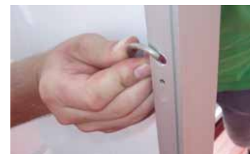
Atornillado del anillo de seguridad TRI-VENT
