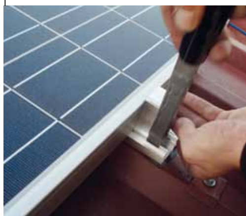
Asegurar los paneles del borde con la herramienta de curvar TRI-VENT
