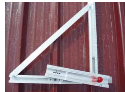
Ajuste de la distancia de los agujeros en el perfil y en las canaletas altas
