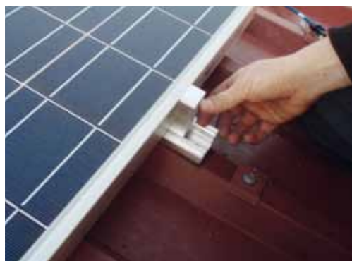
Introducción del anclaje de paneles para extremos
